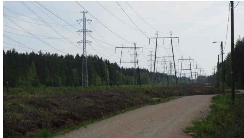
Kuva 52: Voimajohtopylväät hallitsevat avointa maisemaa. Linjan suuntaisesti ja poikki kulkee useita eritasoisia ulkoilureittejä ja polkuja.
