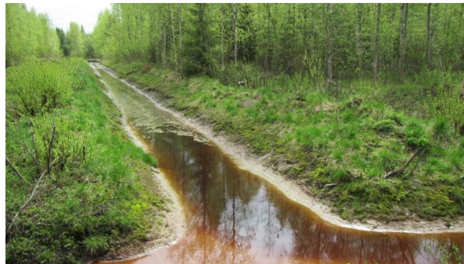
Kuva 57: Uutta suoralinjaista ojitusta alueen eteläosassa. Maasto on rakennettua ympäristöä ja muutamia kuivahkoja kankaita lukuun ottamatta luontaisesti melko kostea.
